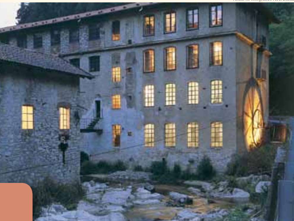
La Fabbrica della Ruota di Pray, ex lanificio Zignone. Si nota la struttura multipiano di stampo manchesteriano.
